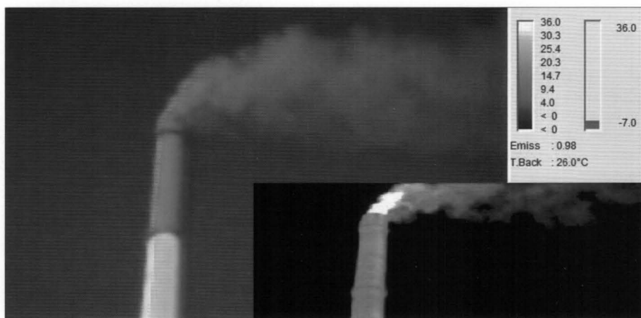
Рис. 3. Фото трубы ТЭС и ее термограмма
